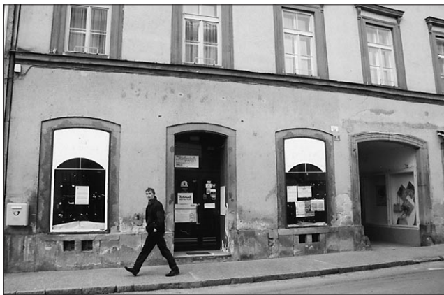
Ena od stavb v Slomškovi ulici, ki še čaka na vrnitev - v njej je bila do konca leta 2001 prodajalna Prehrana. Foto: Črtomir Goznik
