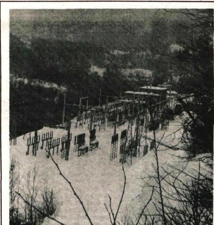
Razširitev stikališča v Mostah — Gradbena dela za razširitev 110-kilovoltnega stikališča vodne elektrarne Moste pri Zirovnici so se začela že pred dvema letoma, saj je teren tam zahteven. Zavarovati so morali namreč pobočje in urediti odvodnjavanje zemljišča. Tudi montažna dela gredo zdaj že h koncu, zmontirali so dve daljnovodni polji, prek katerih bodo napeljali novo razdelilno transformatorsko postajo pri novi jeseniški elektrojeklarni. Hkrati pa obnavljajo relejno zaščito na vseh dvanajstih poljih.
