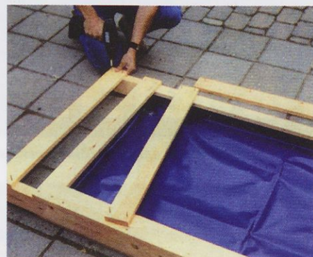
Slika 4. Vzdlž vseh stranic in na oba podaljška privijačite letve s prerezo 90 x 20 mm, ki jim prej obrusite in zgladite vse robove.
