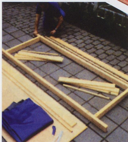
Slika 2. Osnovni okvir bazena je sestavljen iz poskobljanih smrekovih gred s prerezo 90 x 40 mm.
