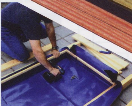
Slika 3. Plastično folijo tik ob zgornjem robu pritrdite s smrekovimi letvicami. Ne uporabljajte žebeljev, ampak samo vijake, da boste bazen ob koncu sezone lahko razstavili.
