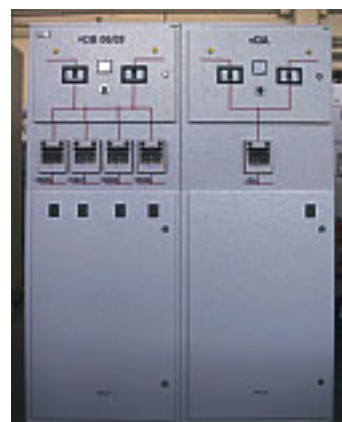
Razdelilna plošča v relejnih hišicah RTP
