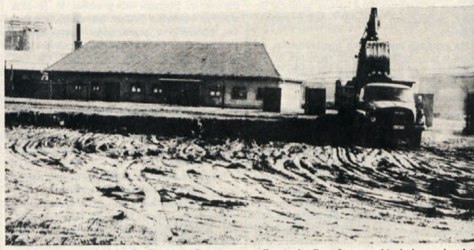
Gradbišče novega obrata družbene prehrane - v ozadju stavba finančnega sektorja in garderoba delovnih oblek
