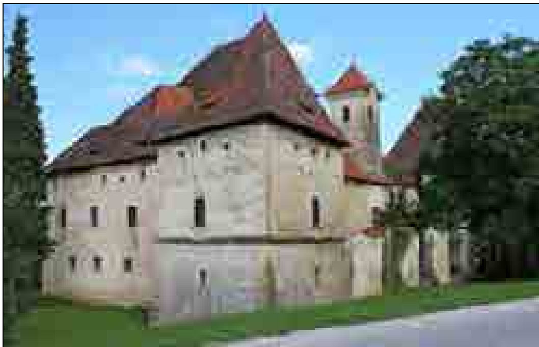
Gracarjev turn je bil prvotno zasnovan kot skromen stolpasti dvor. Ker na vrhuncu turških vpadov takšna stavba prebivalcem ni mogla zagotavljati varnosti, so jo temeljito prezidali in utrdili z dodatnima stolpoma (foto: Tomaž Lazar).
