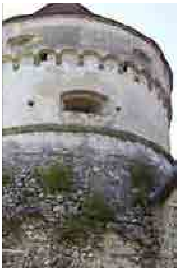
Uporabi ognjenega orožja prilagojeni stolp, s katerim so v 16. stoletju zavarovali izpostavljeni dostop srednjeveškega gradu Lemberg pri Dobrni (foto: Tomaž Lazar).
