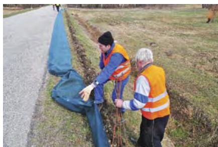
Postavljanje začasnih zaščitnih ograj (foto: K. M.)
