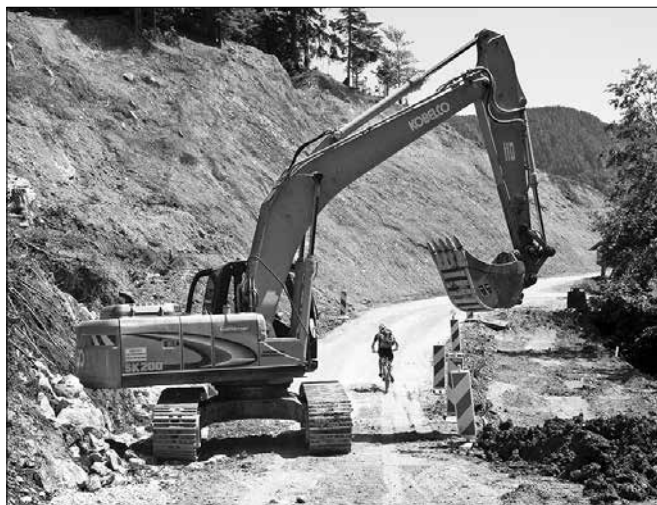
Sanacija plazu na cesti na Klemenščevem je v polnem teku.
