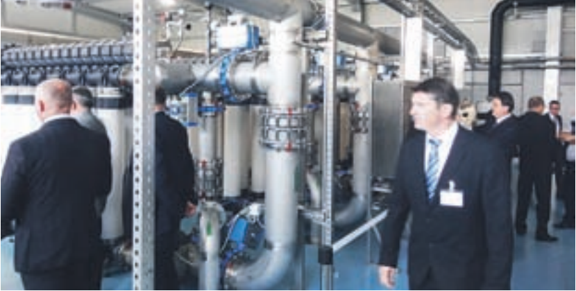
Vse tri čistilne naprave se ponasajo z metodo ultrafiltracije, ki velja za eno najsodobnejših tehnologij v svetu. Za svoje delovanje ne uporablja nobenih kemičnih sredstev.
