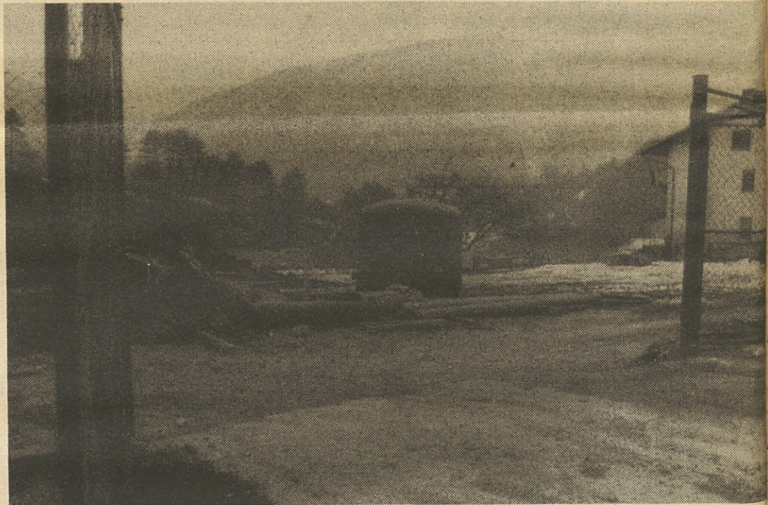
Posoda pripravljena za montažo
