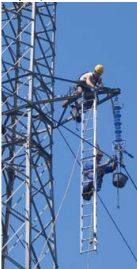
Delavci nameščajo nove kompozitne izolatorje na daljnovodu.
