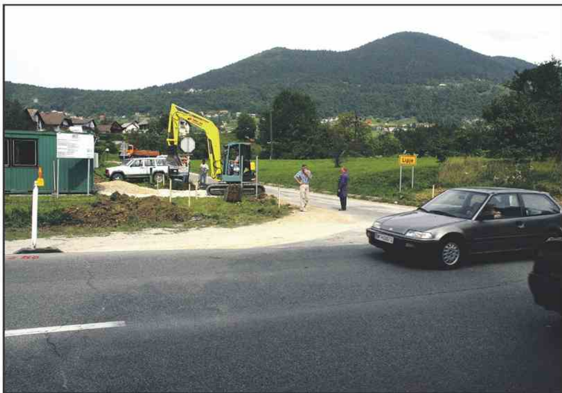
Ta ponedeljek je stekla dolgo pričakovana obnova križišča pri odcepu za Lipje v Vinski Gori.
