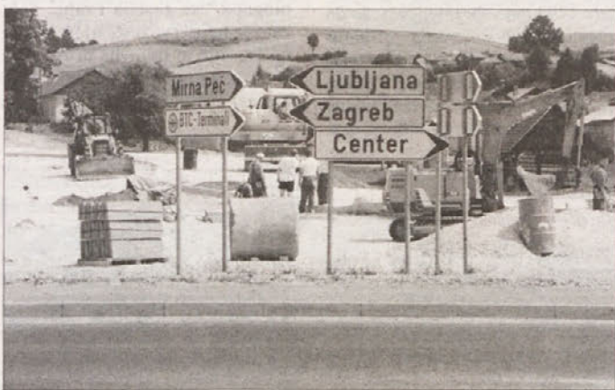
KROŽIŠČE NAMESTO KRIŽIŠČA - V Bučni vasi, kjer se križata Ljubljanska cesta in severna novomeška obvoznica, bo v kratkem zraslo prvo krožišče v Novem mestu, pot do njega pa je bila težka, saj je država, ki bo morala poravnati večino stroškov gradnje, prvi predlog zavrnila. Krožišče, ki ima številne prednosti pred križiščem, bo v premeru merilo 50 m. (Foto: I. V.)
