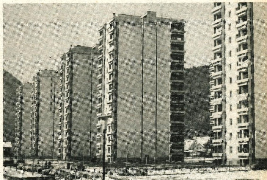
V Podlubniku so lani zgradili dve stolpnici. Za letos je plan enak. — Foto: F. Perdan
