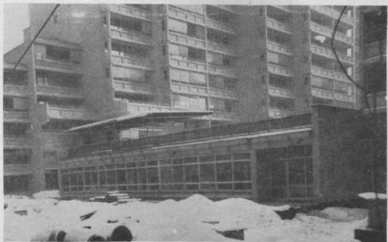
VVZ Poljanska cesta je bilo treba zaradi neugodne lokacije deliti na dva objekta. Prvi, na sliki, je že zgrajen in bo v njem že marca lahko 90 otrok. Junija letos pa bodo začeli graditi vrtec za 60 otrok ob osnovni šoli Toneta Tomšiča.
