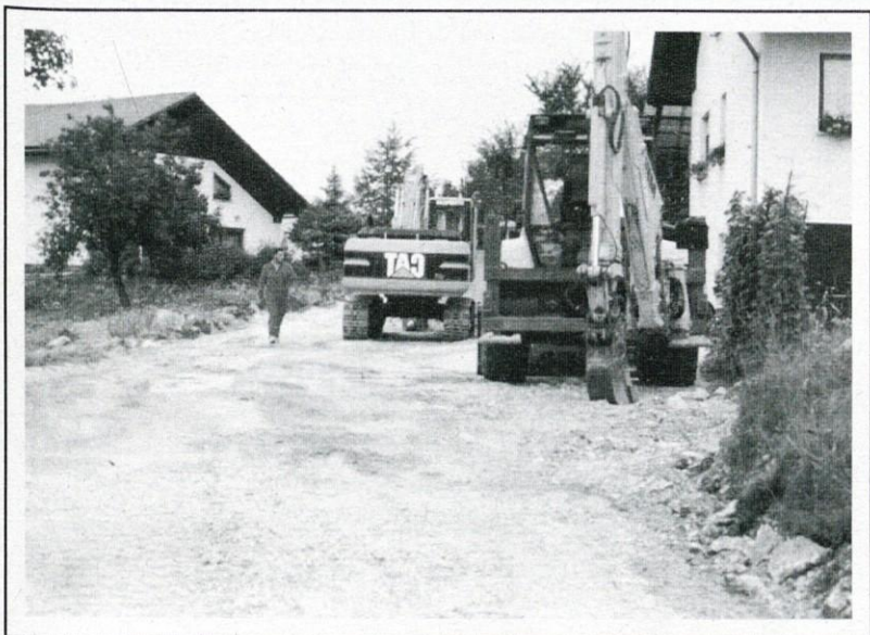
Gradbeni stroji na Režiški cesti. (Foto: F.B.)
