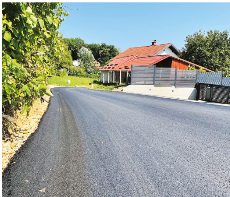
Ulica Vide Alič: preplastili smo cesto in uredili odvodnjavanje v Ulici Vide Alič proti Maistrovi ulici v ČS PANORAMA (v dolžini 120 m).
