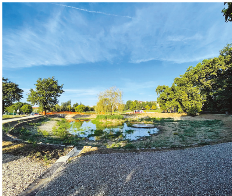
Zagotovitev poplavne varnosti: konec marca so se začela dela v sklopu izgradnje suhega zadrževalnika v Ljudskem vrtu. Ureja se tudi ribnik, ki se bo izpraznil in poglobil, brežine se bodo ob cesti zavarovale z leseno oblogo. Dela so v zaključni fazi. Manjkata še krajinska ureditev in namestitve urbane opreme.
