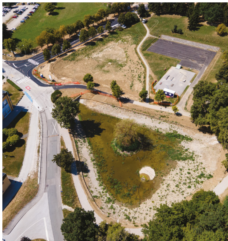
Zagotovitev poplavne varnosti: konec marca so se začela dela v sklopu izgradnje suhega zadrževalnika v Ljudskem vrtu. Ureja se tudi ribnik, ki se bo izpraznil in poglobil, brežine se bodo ob cesti zavarovale z leseno oblogo. Dela so v zaključni fazi. Manjkata še krajinska ureditev in namestitve urbane opreme.
