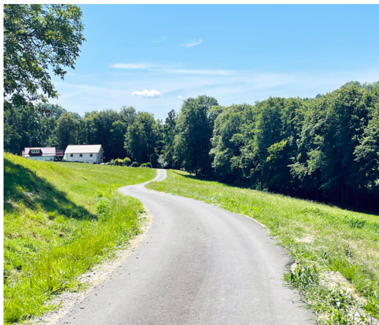
Grajenščak: preplastili smo javno pot Grajenščak v ČS GRAJENNA (v širini 4 m in dolžini 348 m).
