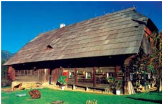
Slika 3: Zgodovinska masivna lesena gradnja (kladna gradnja): Lovrenc na Pohorju. (Vir: Hiše, let.2, dec. 2000, št. 6.) Historical solid timber construction (log structure): Lovrenc na Pohorju.
