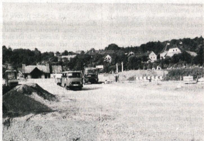
PREUREJAJO POKOPALIŠČE NA VRHNIKI — Komunalno podjetje je v prvi polovici junija 1995 pričelo izvajati ureditvena dela na vrhniškem pokopališču. Načrt ureditve je delo arhitekta Alojza Drašlerja z Vrhnik. Ureajo dostopne poti, ki bodo obrobene z granitnimi kockami ter asfaltirane. Osrednja poslovilna ploščad je že dobila obliko kroga, poudarjena z granitnimi kockami, jeseni pa bo rob obsajen z živo mejo iz gabra, ki bo dajala zvočno in vizuelno zaveso nasproti Tržaški cesti. Ploščad bo prav tako asfaltirana. Ker z ureditvijo ne bo več dovoljeno parkiranje na ploščadi, gradijo tudi parkirišče s približno 50 prostori. Za potrebe odvodnjevanja bodo položili kanalizacijo. Za osvetlitev ploščadi in parkinga je položen nov električni kabel. Dela bodo predvidoma končana v prvi polovici avgusta.
