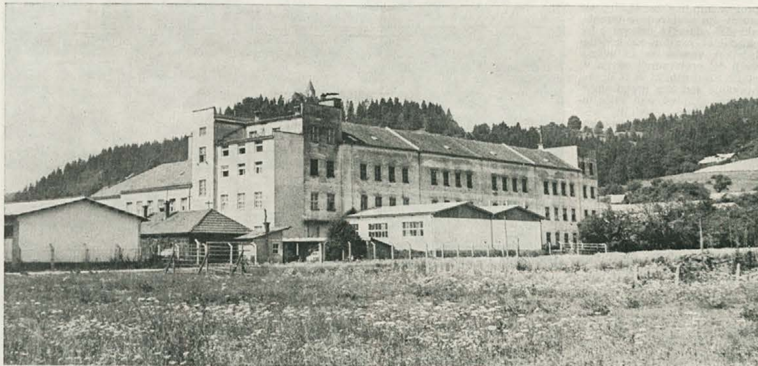
TOZD Nova oprema Slovenj Gradec — foto: F. Jurač
