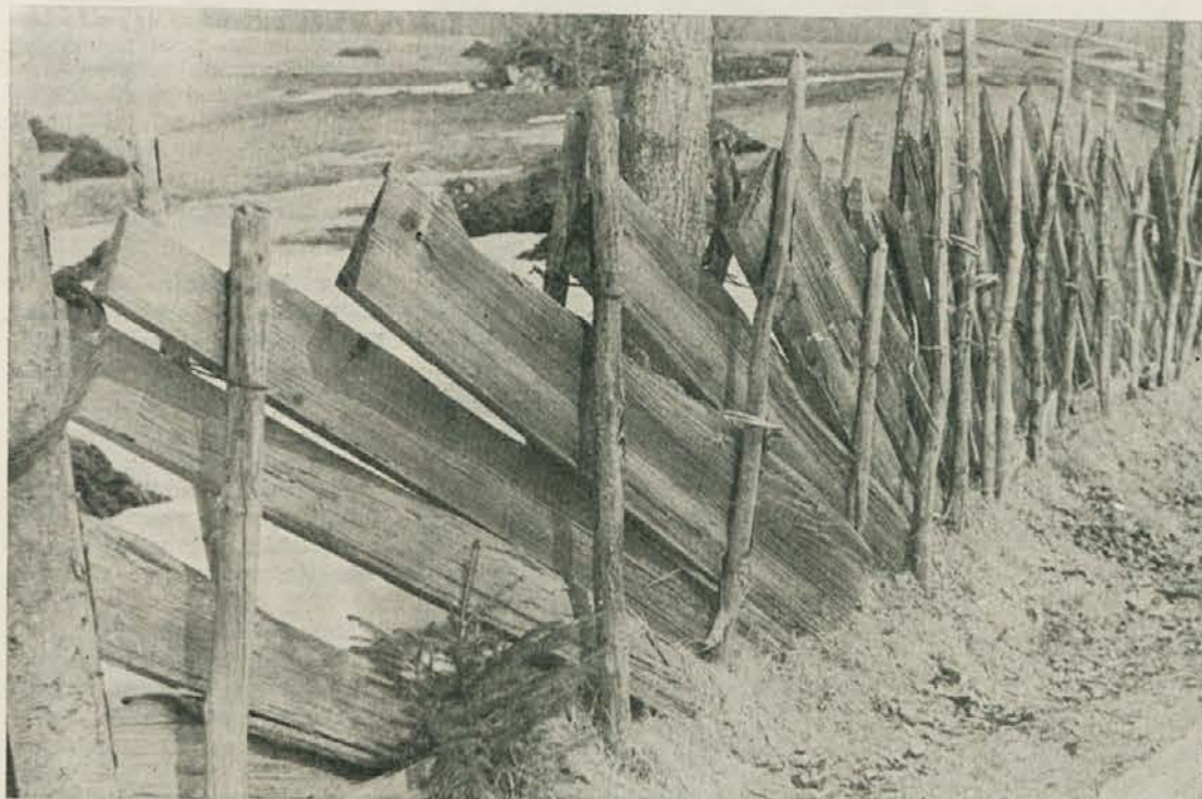
»Šikel za šiklom« (škodlja za škodljo) ... in »plot« že stoji. (koroška ograja) — foto: A. Klemenšek
