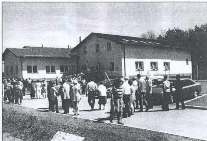
Novi prostori Nacionalnega veterinarskega inštituta.
