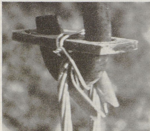
Zavarujemo sidra z varovalno ploščico predenj obremenimo žičnice.
