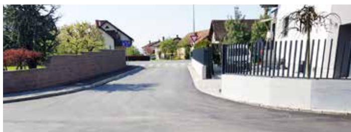
Pri izvozu s Šubljeve na Grobeljsko cesto je bila izdelana tudi trapezna hitrostna ovira s prehodom za pešce, s katero se je, predvsem za pešce, bistveno izboljšala prometna varnost
