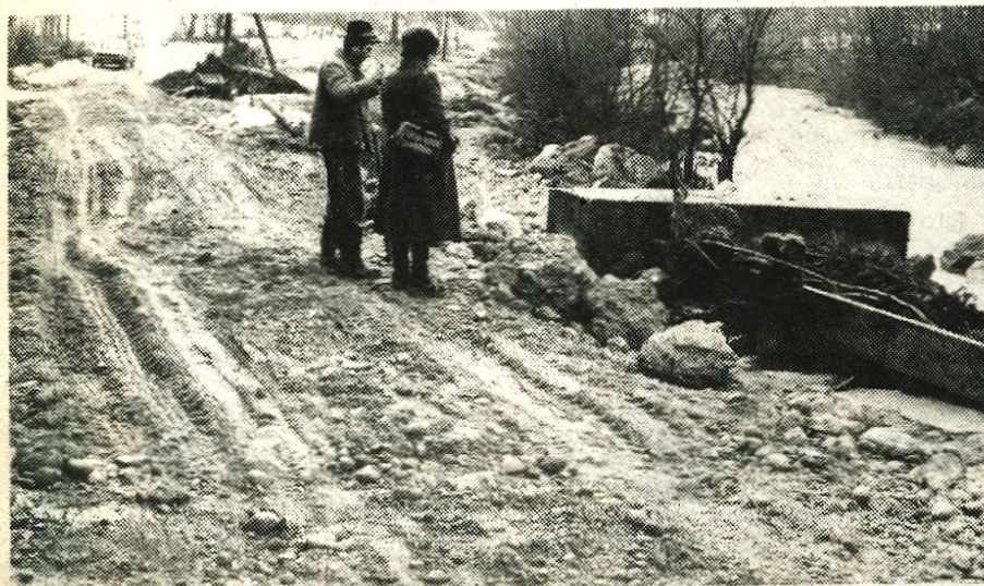
Poškodovano obrežje in cesta od Slapa proti Dolini
