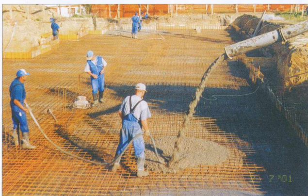
Temeljna plošča ob začetku gradnje 18-stanovanjskega bloka
