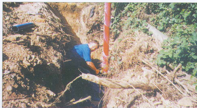
Uslužbenec Blisk Montaža g. Črnko Vendel pri montaži hidranta
