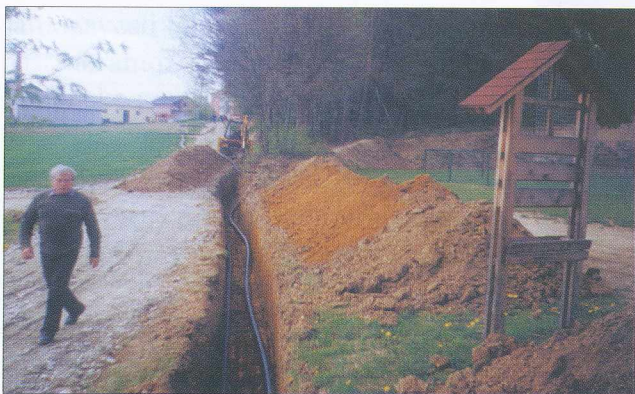
Prvi metri polaganja vodovodnih cevi v smeri proti vrtini, tako imenovani krak 4
