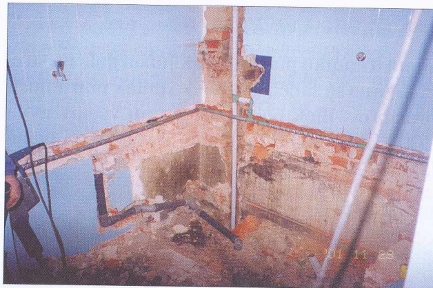
Zamenjava dotrajane instalacije v bloku pri občini
