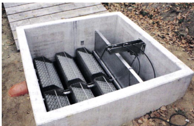
Slika 12 • Dve fazi inštalacije opreme (brez odtočnih korit in z njimi)
