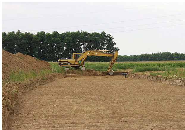
11 Strojni izkop ornice z večjim bagrom.
