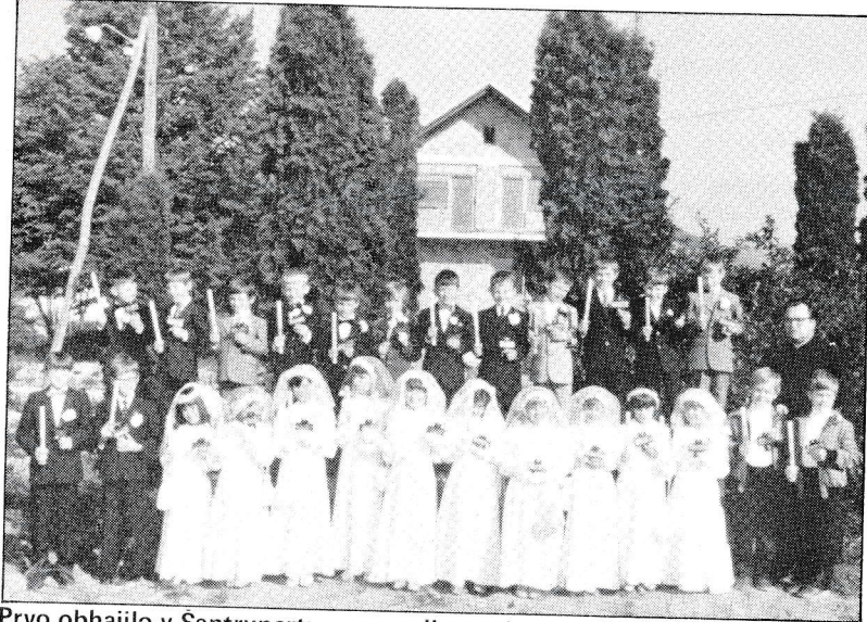
Prvo obhajilo v Šentupertu — v ozadju stavba novih učilnic
