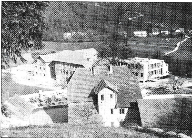
Srednja verska šola v gradnji
