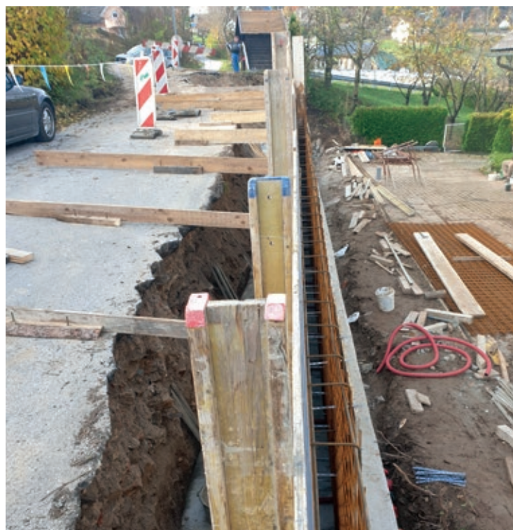
Nastaja nov oporni zid ob cesti na Golem.
