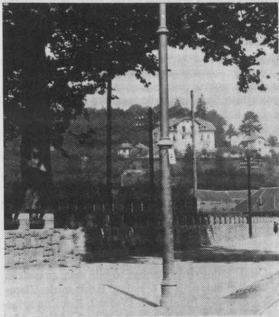
Del električne napeljave ob Celovški cesti (o. 1930) (ZAL, fototeka POZ IIA/3-669)
