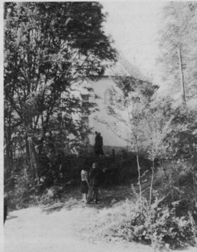
Cerkvica sv. Mohorja je obnovljena
