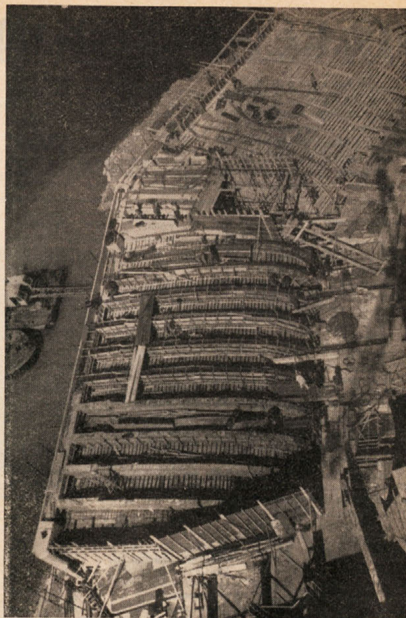
Pogled na tesarski opaž sekundarnih lokov objekta restavracije v Kraljevici. Sekundarni loki ležijo kot prosti nosilci na glavnem primarnem loku
