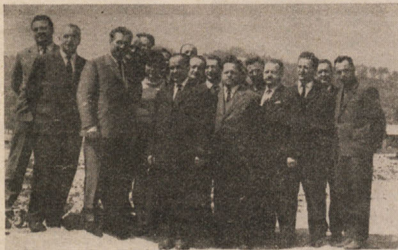
Dne 11. 5. je imel strokovni kolegij podjetja seja na gradbišču v Štorah, kjer si je po končani seji ogledal še objekte v izgradnji
