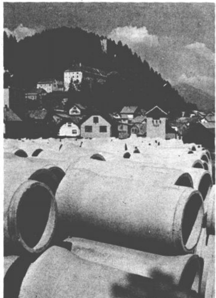
V krajevni skupnosti Šoštanj ne počivajo tudi v teh poletnih dneh, saj urejajo toplovodno napeljavo na levem bregu Pake. Istočasno pa gradijo tudi kolektor.
