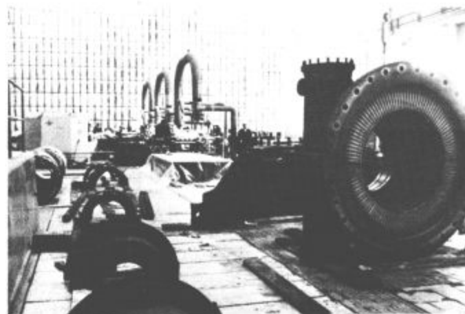
Remont četrtega bloka je obsežen, poteka že vse od začetka aprila, sklenili pa naj bi ga sredi avgusta. Obnovitvena dela bodo veljala okoli 80 milijonov dinarjev, 170 milijonov pa bodo namenili še za zmanjšanje dušikovih oksidov na tem bloku
