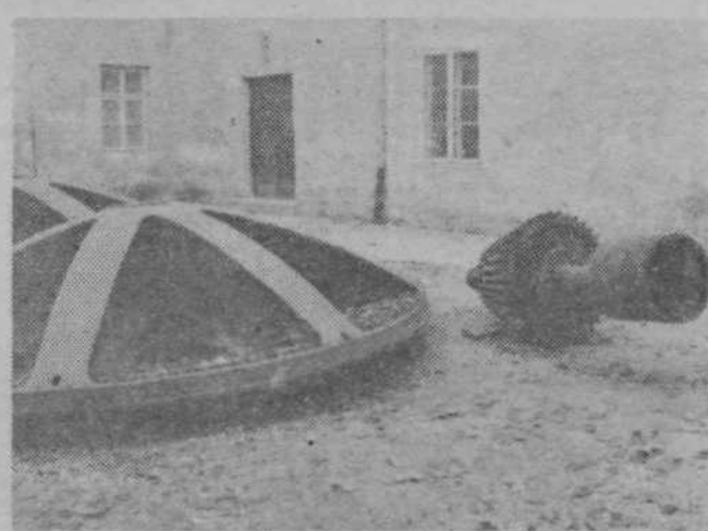
Multiplikator dotrajane Andritzove turbine vevške elektrarne na Ljubljani je imel vgrajene še lesene zobe. Na dvorišču fužinskega gradu čaka na prevoz v tehnični muzej.
