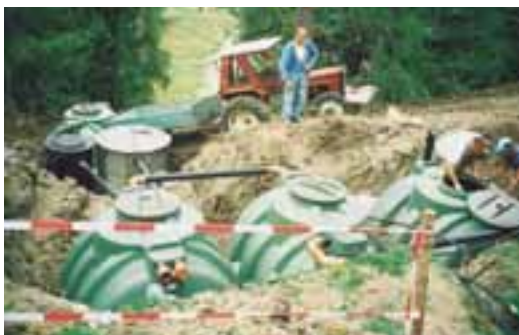
Montaža čistilne naprave (foto: Danilo Sbrizaj)
