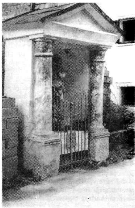
Zdaj že podrta kapelica na Racovniku v Železnikih
