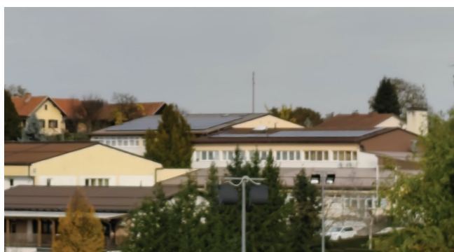
Sončna elektrarna na strehi OŠ Sveti Tomaž
