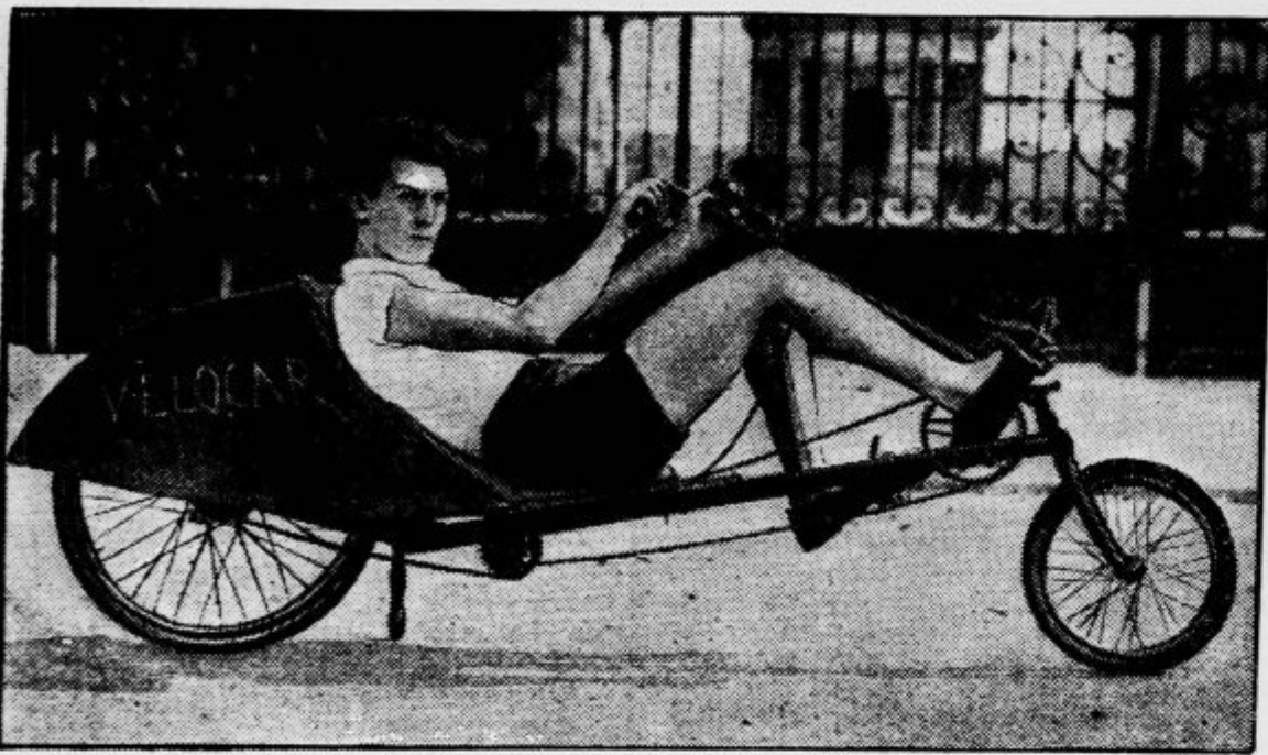
Neki Parizan je skonstruiral to svojevrstno kolo, ki se poganja s rokami in nogami hkratu. Ker potrebuje dvakrat toliko pogona kakor bicikelj, je tudi dvakrat urnejše od njega.
