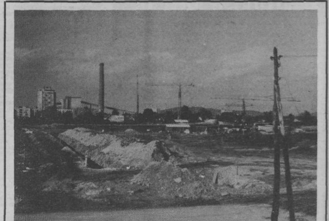
Podjetje za urejanje stavbnih zemljišč Soseska je v Štepanjskem naselju začelo pripravljati zemljišče za gradnjo velike demonstracijske stanovanjske soseske. To kaže tudi posnetek. Buldožerji so globoko zaorali v ledino in če bo šlo vse po načrtu bodo že prihodnje leto zrasle iz tal nove stolpnice
