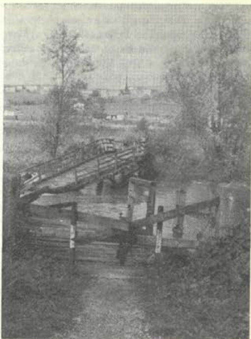
Povodenj je porušila most iz Prvačine proti Gradišču
