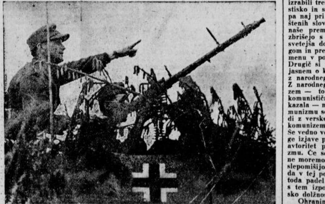
Im Mittelabschnitt der Ostfront. — Sturmgeschütze treten zum Gegenstoss an. Na srednjem odseku vzhodnega bojišča. — Napadalni topovi stopajo v protinapad. Fk. Aufn. Atlantic Bilderdienst
