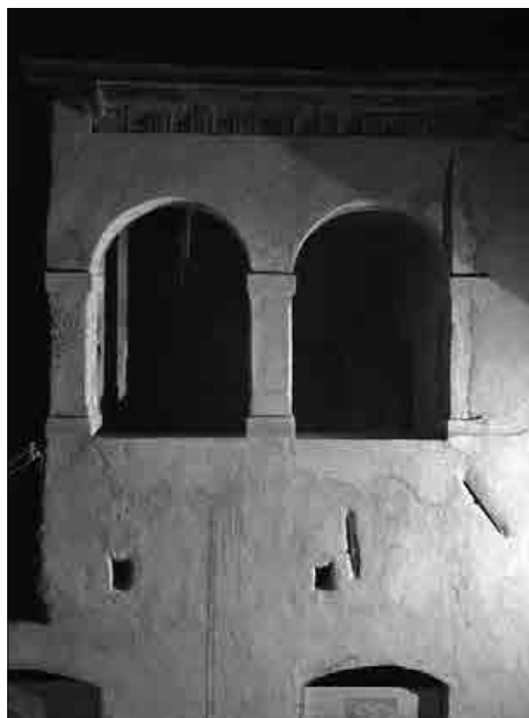
S sondažnimi raziskavami odkriti sledovi renesančne arkadne galerije na vzhodnem traktu in ponovno odprti arkadi na dvorišni fasadi severnega trakta (Igor Sapač, 2014).
