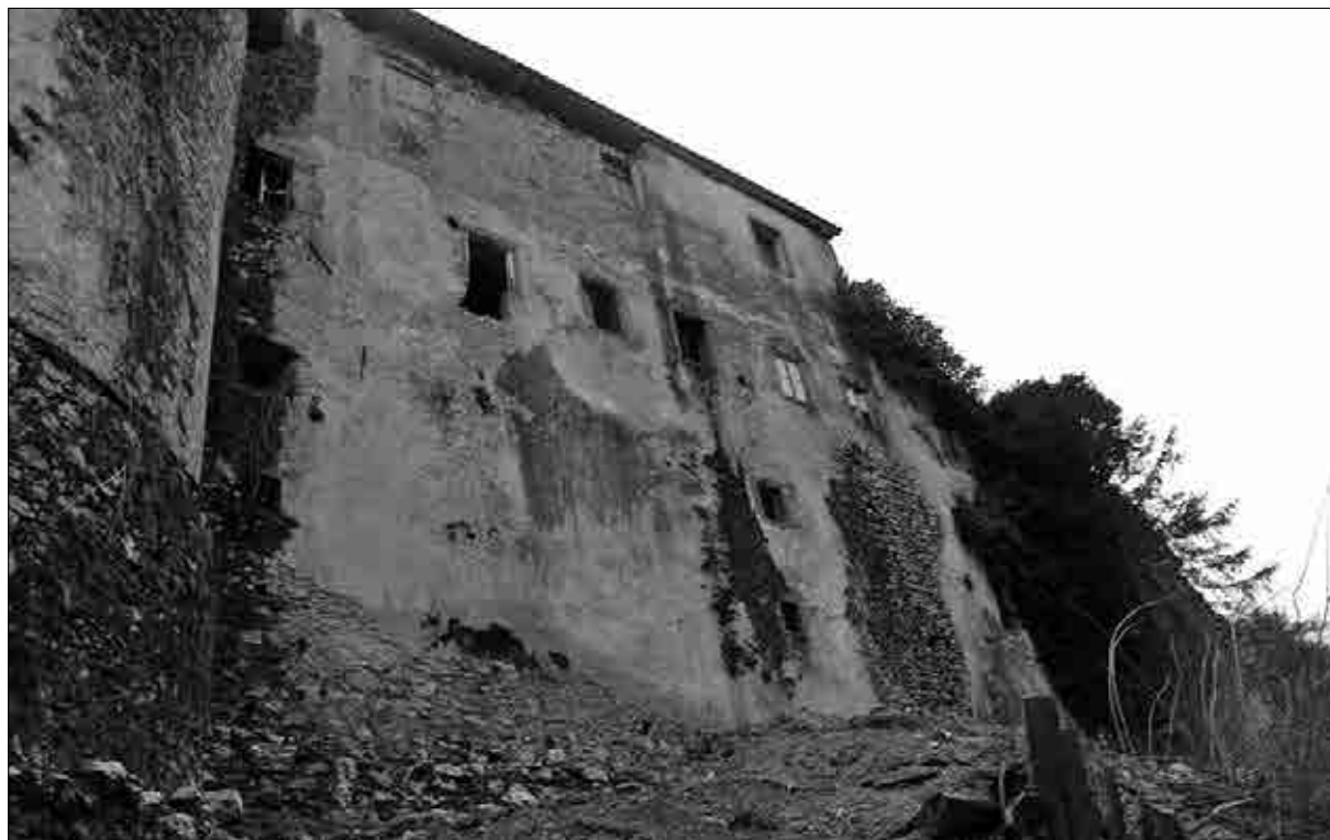
Severna fasada severnega trakta gradu Lemberg s sekundarno nadzidano vrhno etažo (Igor Sapač, 2012).
