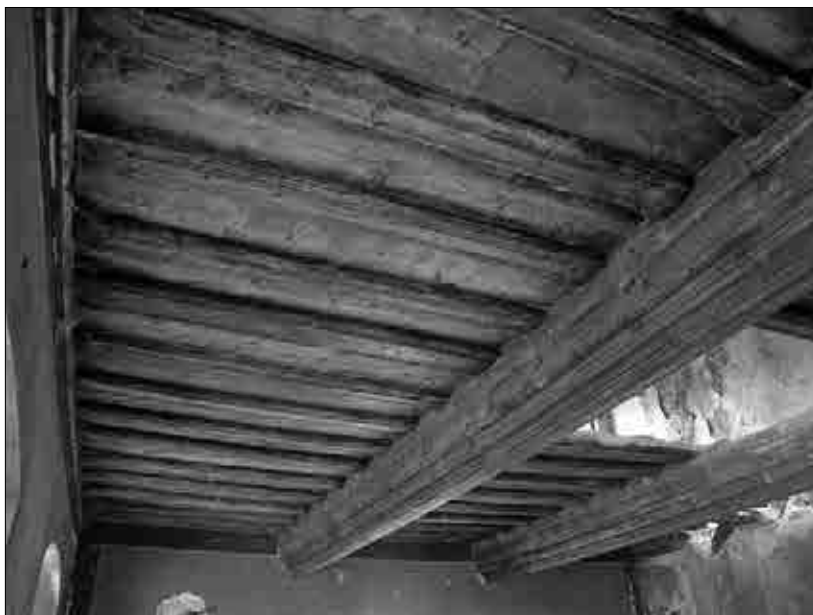
Renesančni profilirani leseni strop v vzhodnem prostoru pritličja južnega trakta (Igor Sapač, 2006).
