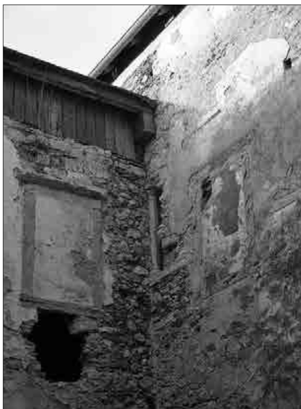
S sondažnimi raziskavami odkriti sledovi renesančne arkadne galerije na vzhodnem traktu in ponovno odprti arkadi na dvorišni fasadi severnega trakta (Igor Sapač, 2014).
