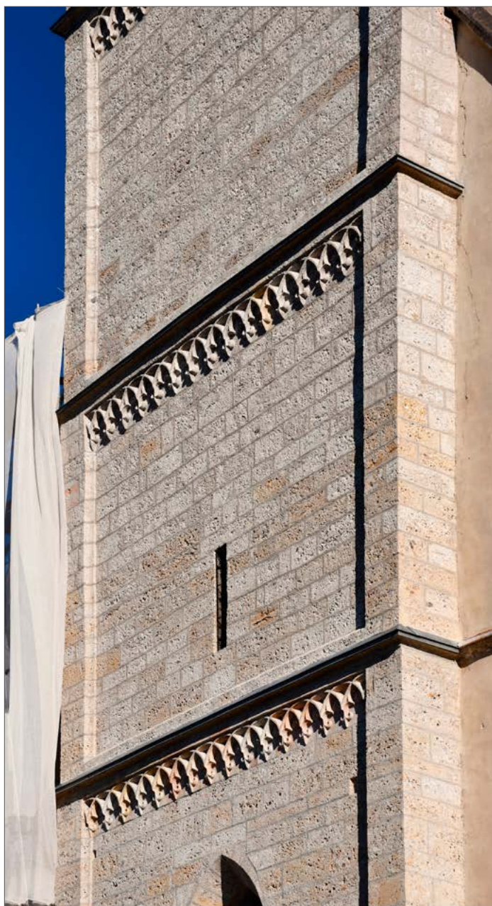
3. Peščenjak in konglomerat na fasadi zvonika v Kranju (© ZVKDS, foto: Matevž Remškar)
