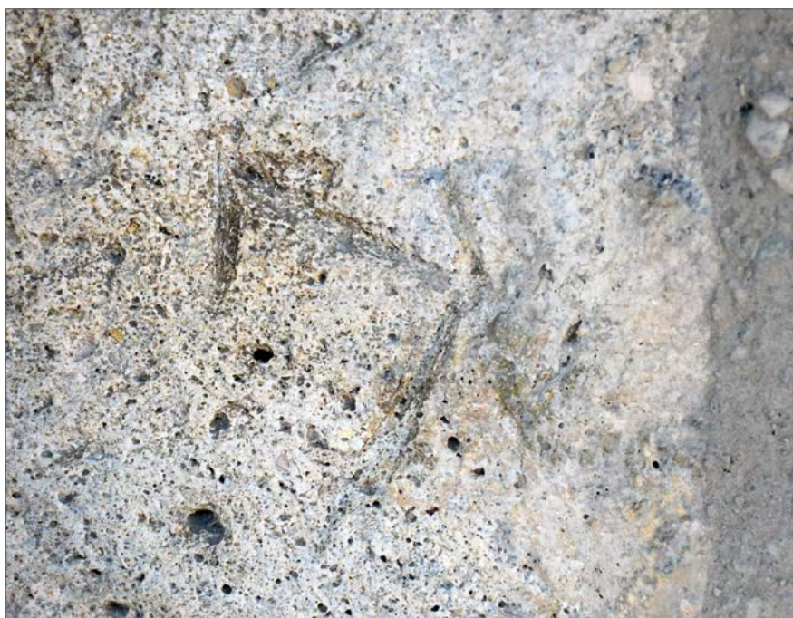
8. Znak Mojstra kranjskega ladijskega oboka na tretjem slepem trilstu najvišjega venčega zidca v Kranju (© ZVKDS, foto: Matevž Remškar)
