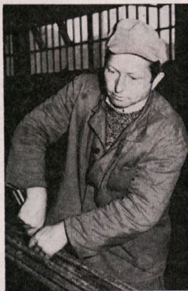
Štefan Turščak, naš najboljši železokrivec, pri vezavi v delavnici
