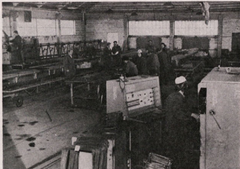
V železokrivski delavnici je vedno živahno, saj dela ne zmanjka
