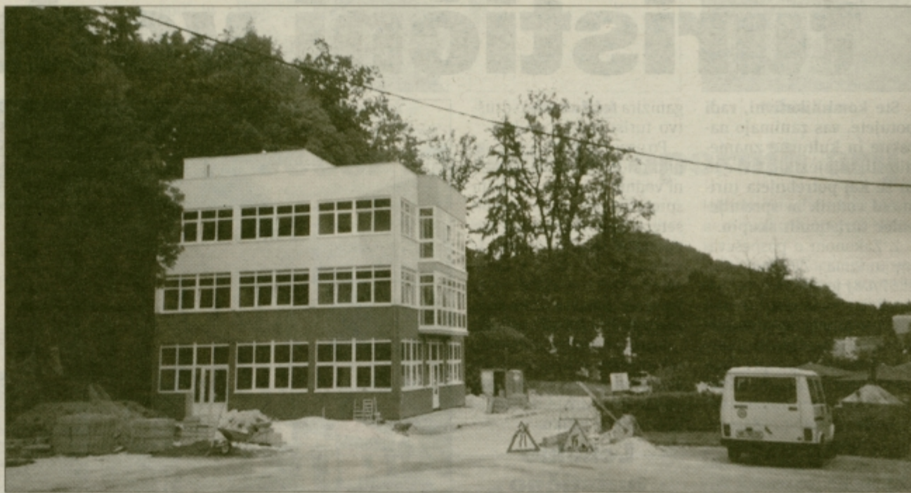
Dom obrtnikov v Rogaški Slatini je postavljen na zemljišču v lasti Območne obrtne zbornice iz Šmarje pri Jelšah. Moderna gradnja je na zanimivi lokaciji, nasproti poslopja restavracije Sonce, ki letos praznuje 200-letnico.
