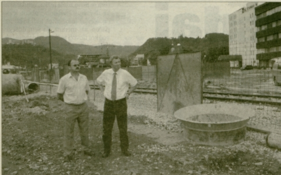
Iztok Uranjek in Miran Gajšek na gradbišču novega železniškega mostu, čez katerega bo promet stekel v drugi polovici septembra.
