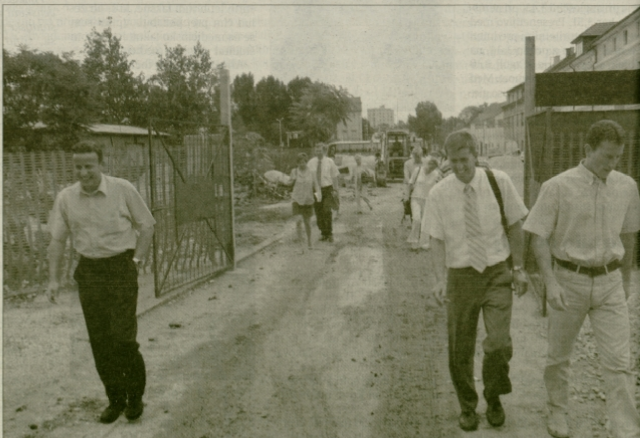
Bojan Šrot, Silvo Plesnik in Marjan Gaberšek niso skrivali veselja, da dela na gradbišču Mariborske tako dobro napredujejo.
