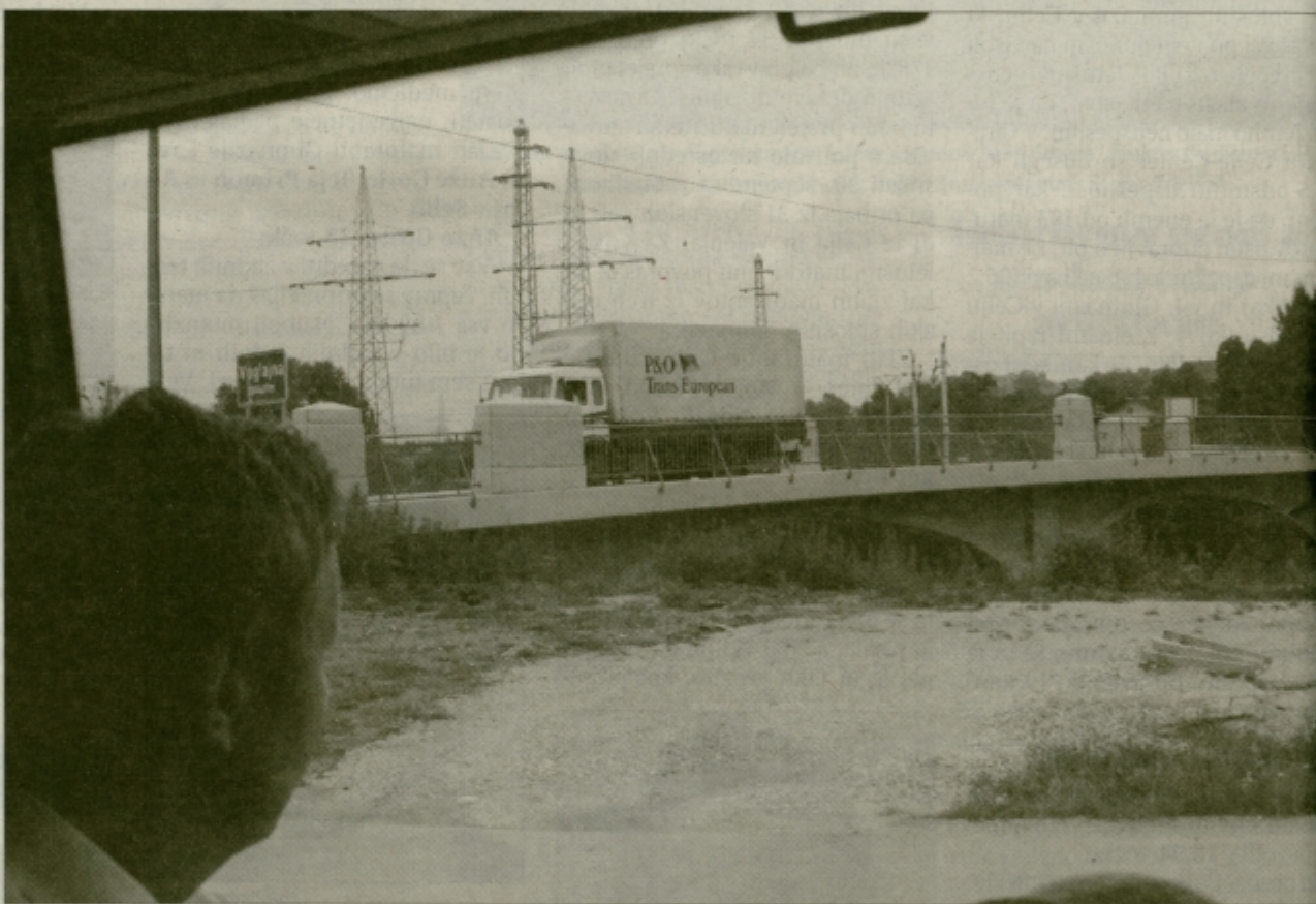
Pocajtov most so za okoli 70 milijonov tolarjev obnovili in utrdili delavci CM Celje.
