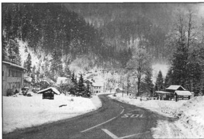
Z novima avtobusnima postajališčema na primernem prostoru bodo ustregli potnikom, odpravili prometne zagate v najožjem delu kraja in obenem poskrbeli za večjo prometno varnost
