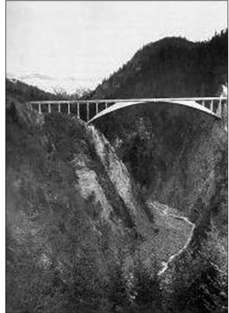
Abb. 15, Abb. 16 Robert Maillart, Salginatobelbrücke Schiers/Schweiz 1929/30 15 Gesamtansicht 16 Zufahrtskonstruktion
