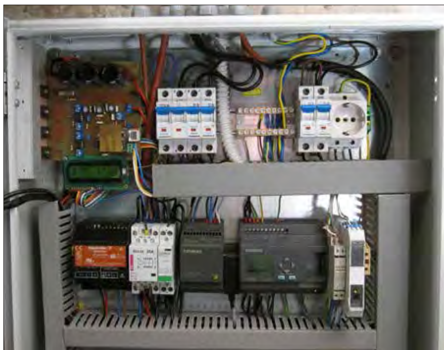
Slika 6. Pogled na krmilni sistem v omarici, zgoraj levo vezje MPP-sledilnika
