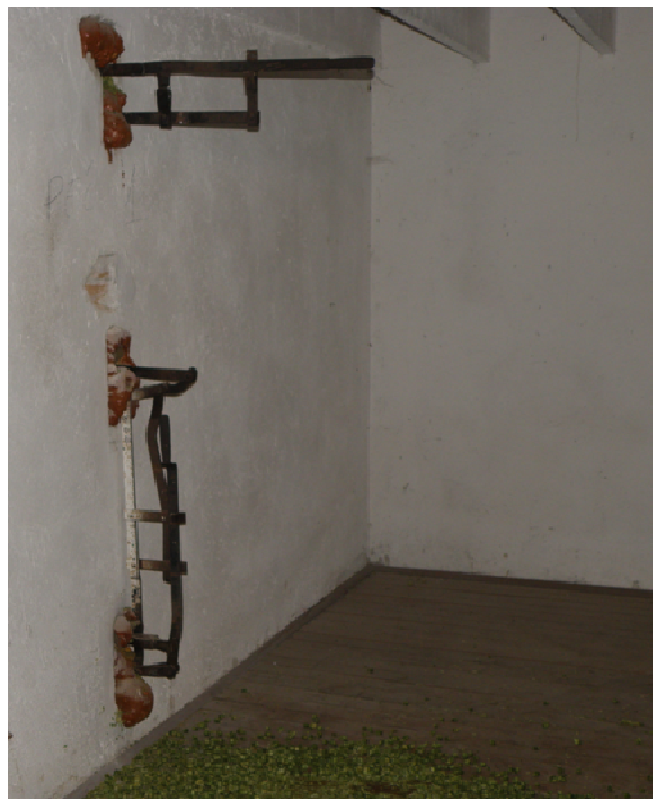
Takšne naprave pa so uporabljali včasih. Mehanizem za ročno spuščanje hmelja v hmeljski sušilnici. (foto: Davorin Vrhovnik).
